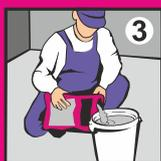
3 Для подготовки раствора залейте водопроводную воду комнатной температуры в чистую ёмкость из расчёта 6,2-6,8 л воды на 1 мешок 25 кг.
